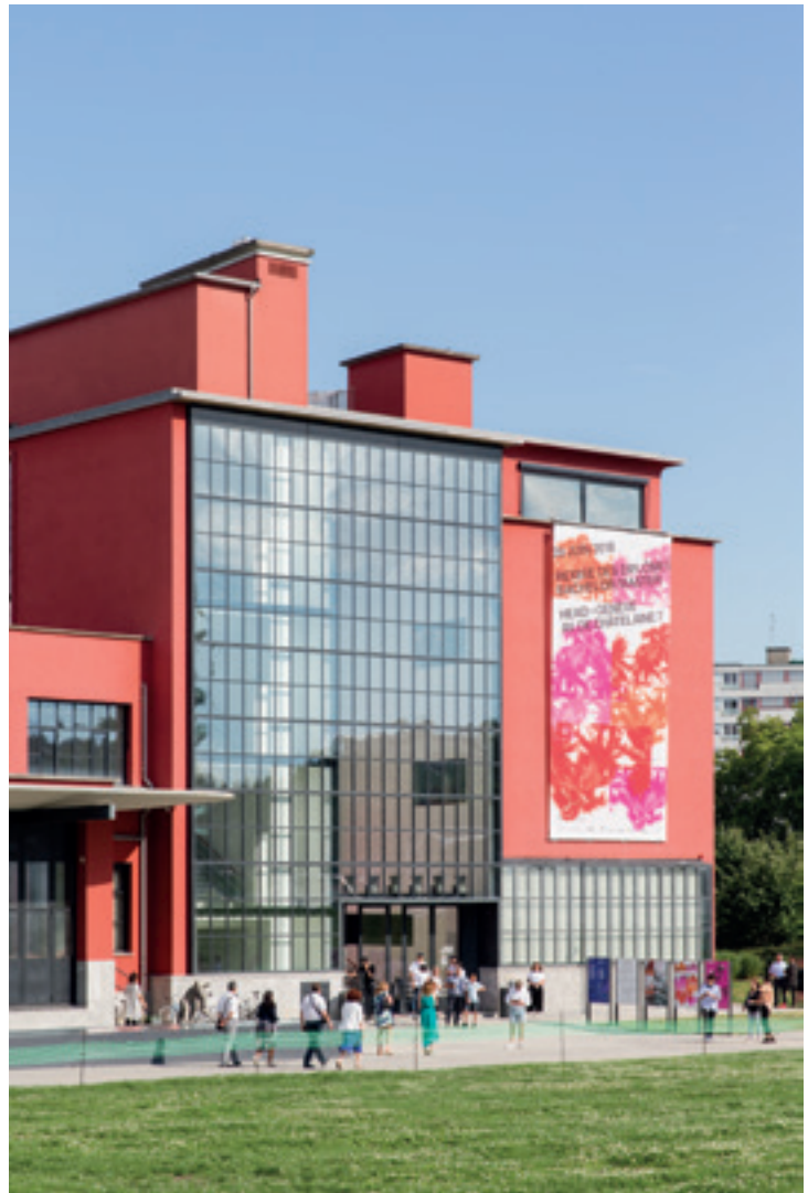
Vue de la façade du HEAD, Genève, 2018.
